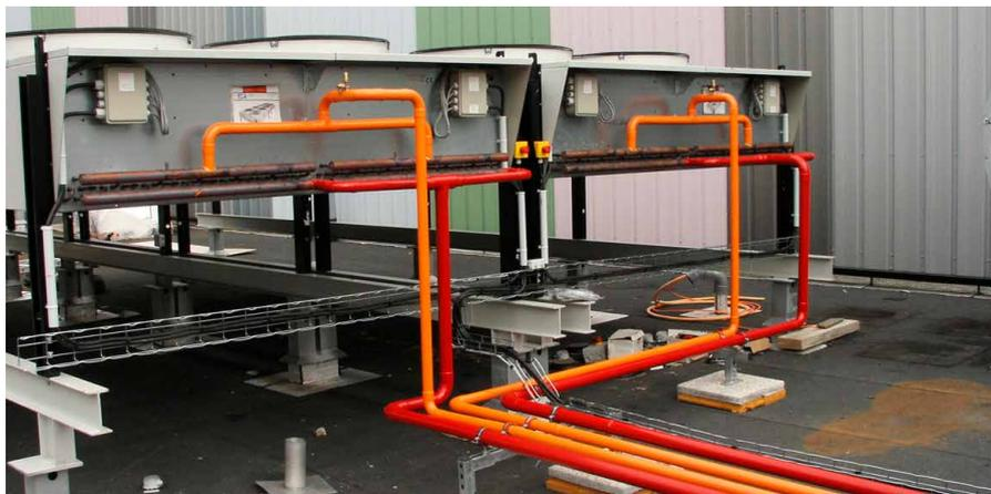
Impianto di raffreddamento per compressori d'aria con dry cooler
