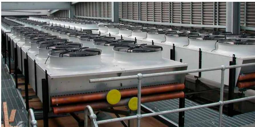
Dissipatori di emergenza per impianto di cogenerazione
