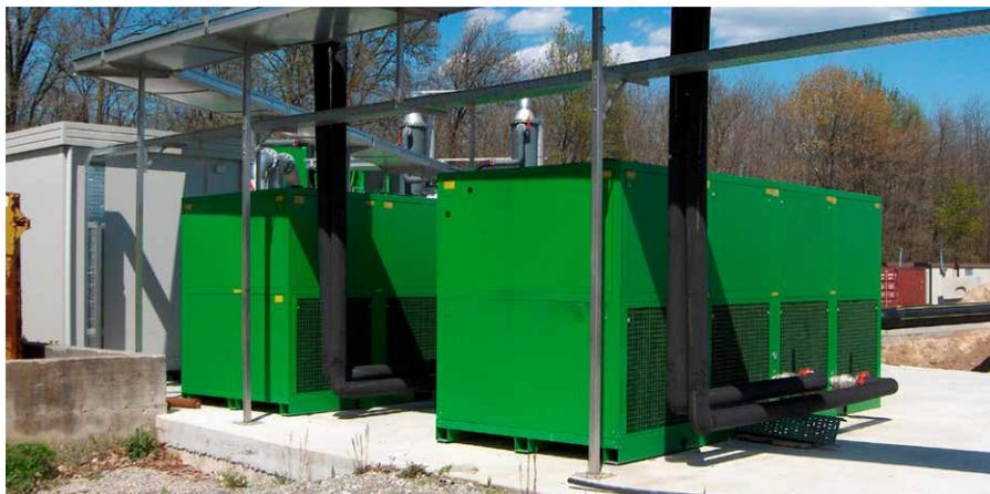
Sistema per la deumidificazione del biogas
