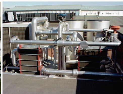
Una nuova interessante applicazione, che ormai è diventata uno standard, con la possibilità da parte nostra di fornire uno skid con la soluzione completa, è il raffreddamento remoto dei telai per la produzione di tessuti sintetici.
