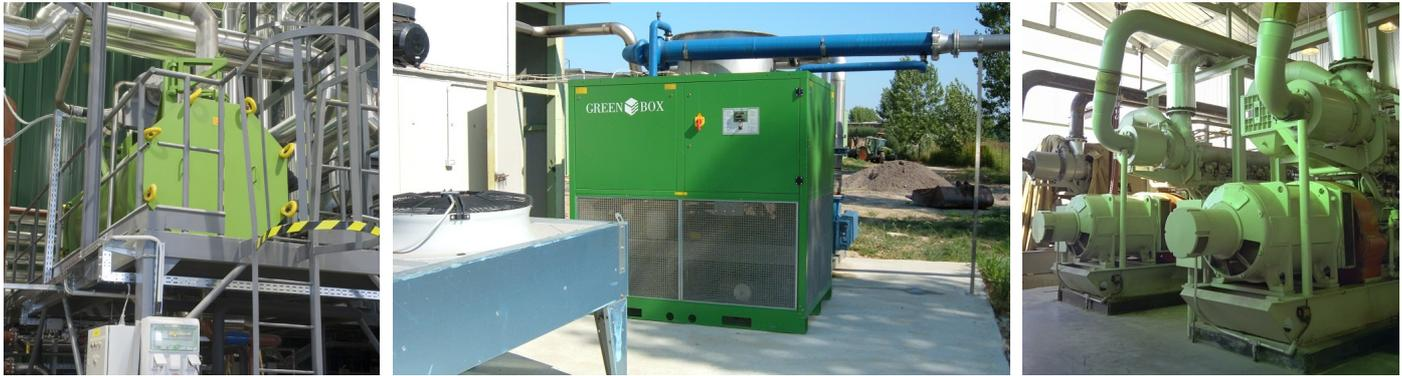
**T RECOGEN BIO** sono sistemi package integrati, per la deumidificazione del biogas per gli impianti di cogenerazione.
